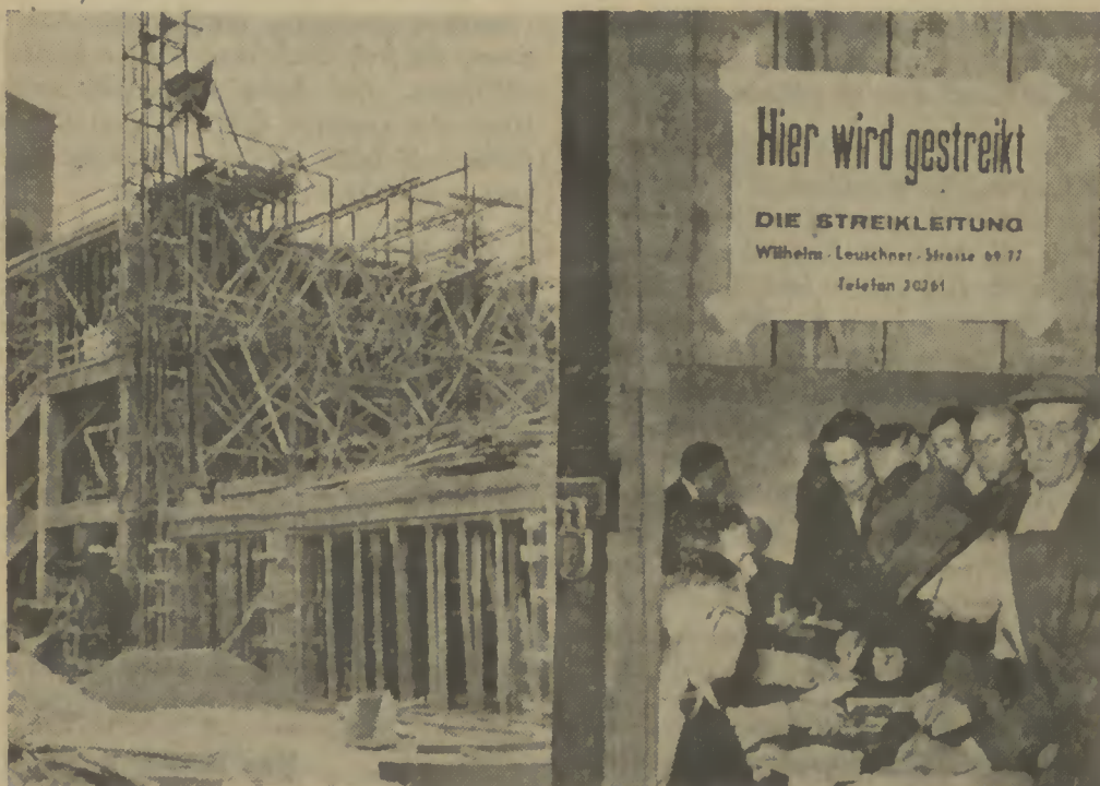
Baustelle der Kaufhof AG. an der Hauptwache in Frankfurt am Main Streikunterstützung wird ausgezahlt
